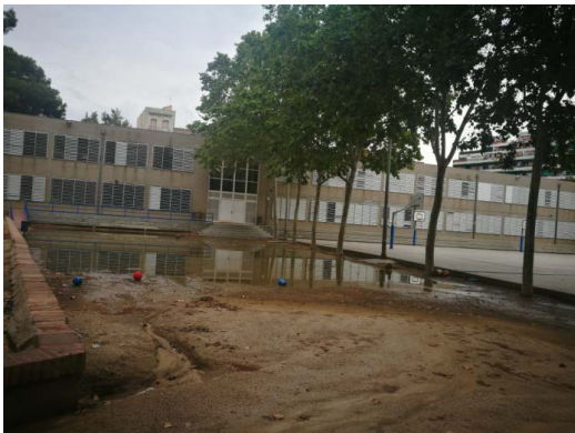
Pati inundat degut a que el drenatge superficial està reblert de sediments (2)
